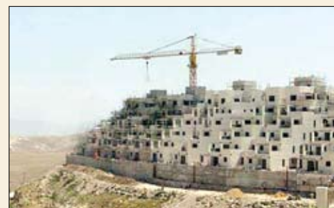
عمليات البناء الجارية في معاليه أدوميم
